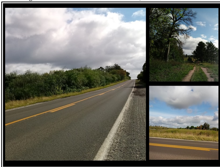
Figura 2 – Estrada de acesso em condições normais de uso
