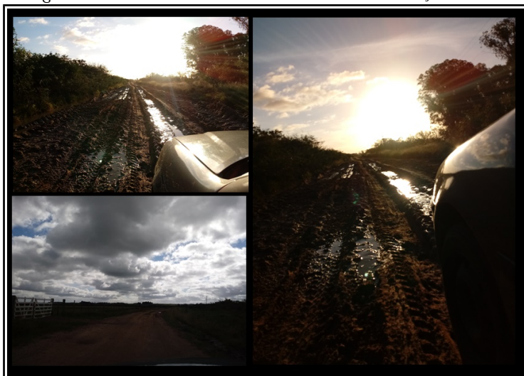
Figura 3 – Estradas de terra do interior em más condições de uso
